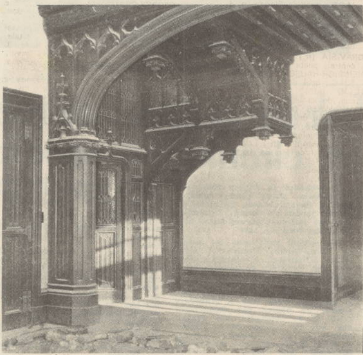
Des boiseries au rez-de-chaussée.
